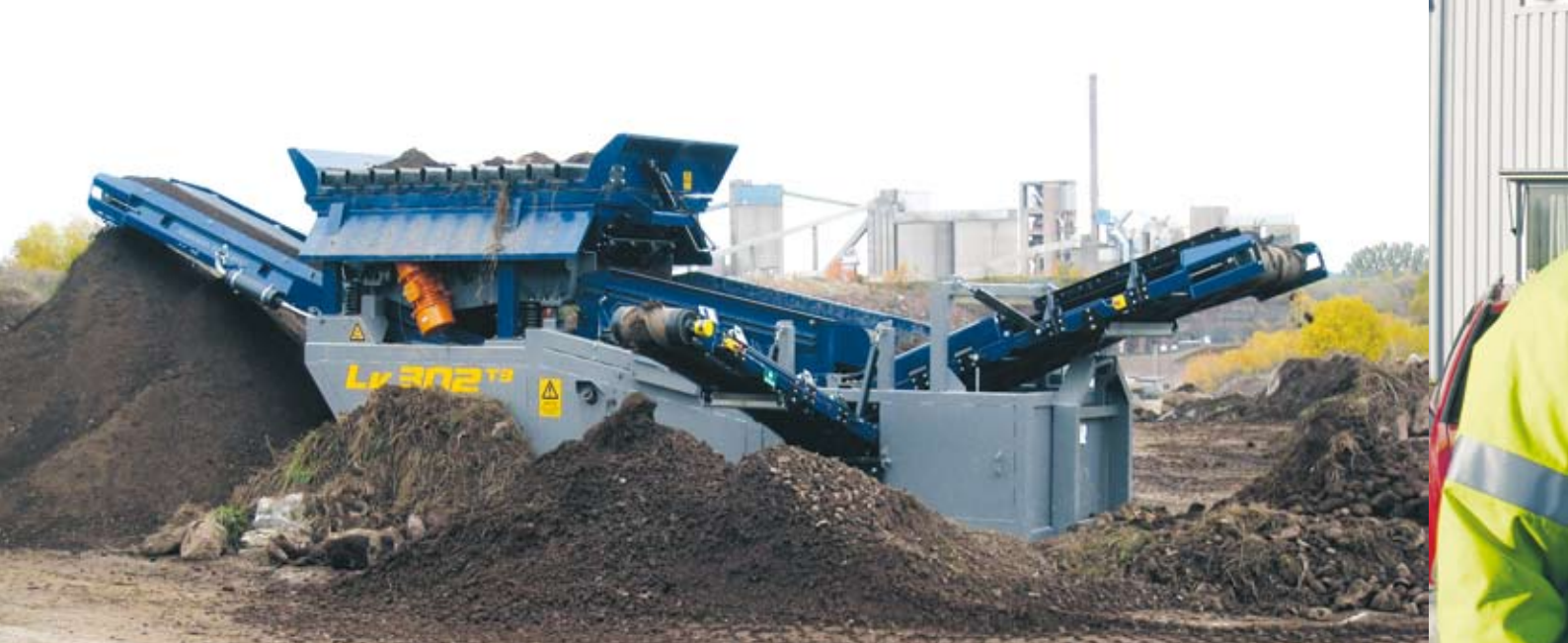
Lv 302 T3 sorterar fram matjord ur avtäckningsmassor i Cementas bergtäkt utanför Skövde. Materialet används sedan i Skanskas anläggningsarbeten.
